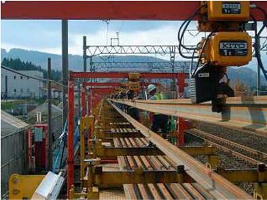
青函トンネル内でのロングレール取卸しと敷設作業
