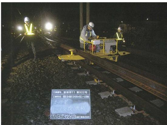
レール交換作業 (端末レール交換機)
