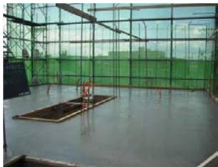
床暖房温水パイピング部分コンクリート打設完了
