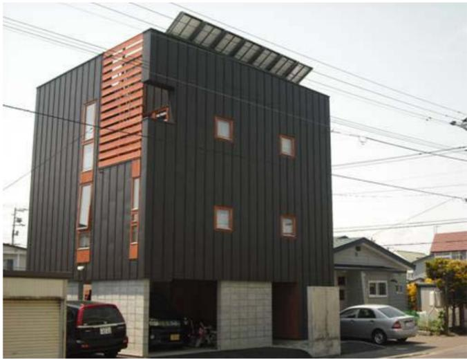
主要構造は補強C B造、断熱は外断熱通気工法(北東面より写す)
