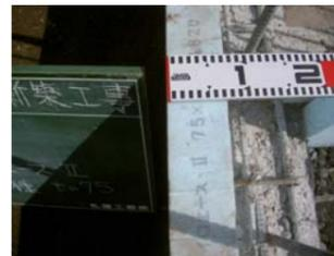
断熱材(t75(B類3種))で基礎断熱
