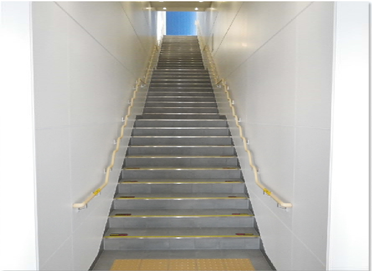
A 階段ホーム階から撮影
